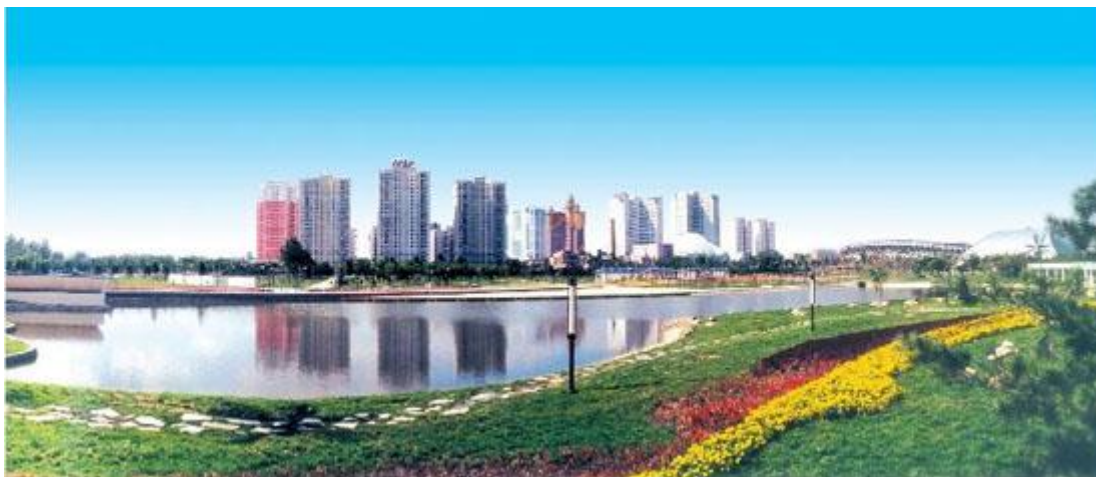
het zuidelijk stadsdeel
